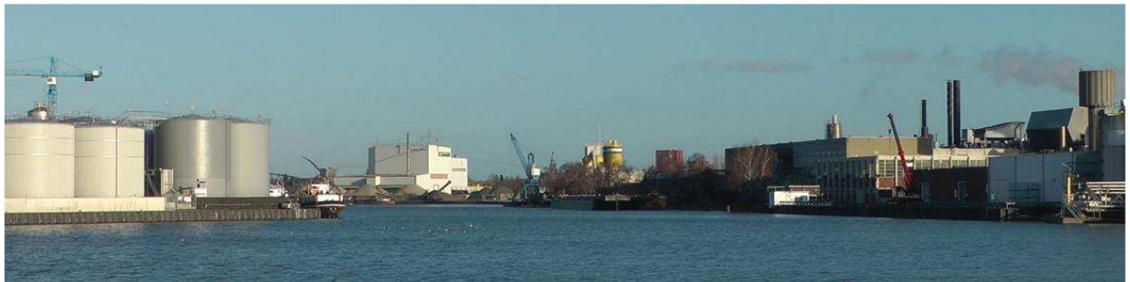
Bedrijventerrein Nijmegen-West (foto Leefmilieu)
